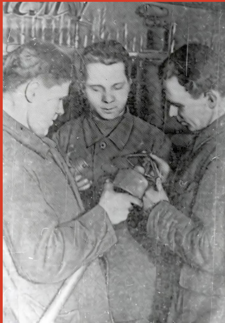
Монтаж бронепоезда, 1942 г.
