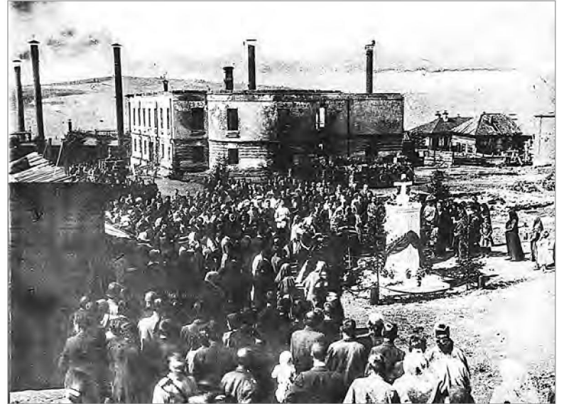
Сегодня сгоревшего здания конторы уже нет. ФОТО ИЗ АРХИВА «ИСКРЫ»
